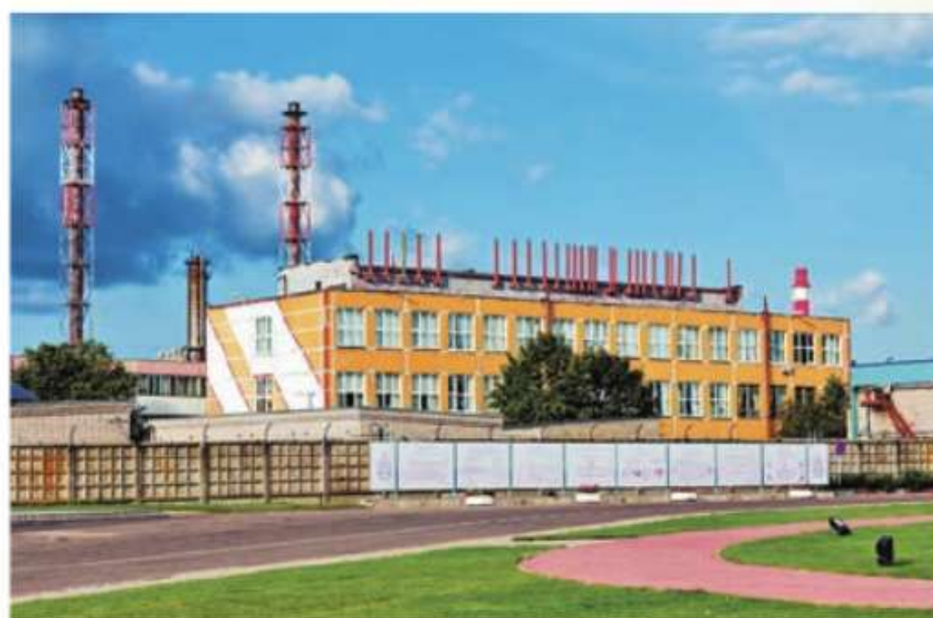
Дорогобуж. Завод по производству минеральных удобрений
