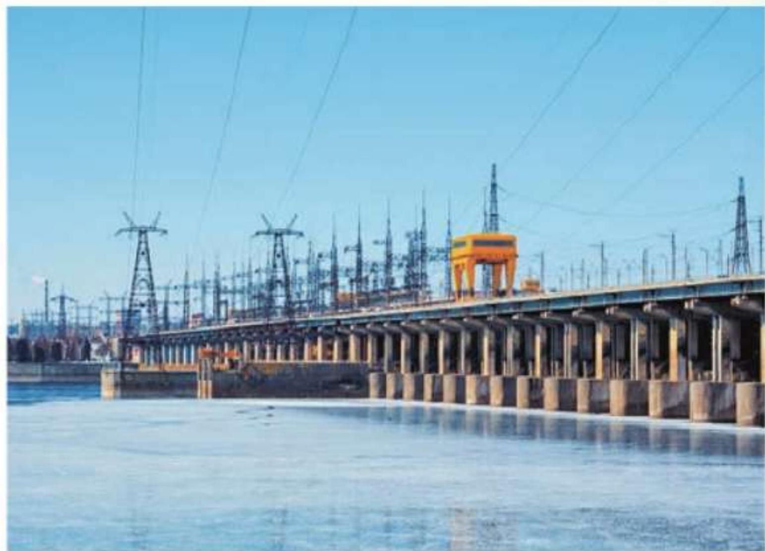
Плотина Волжской ГЭС
