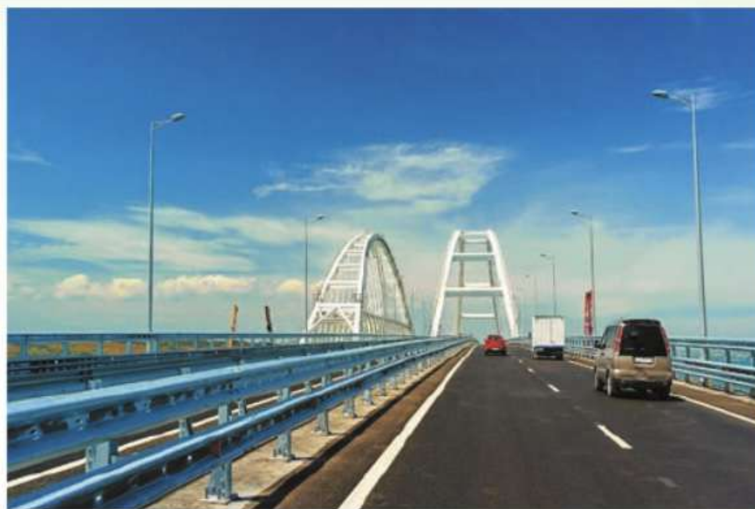
Мост через Керченский пролив
